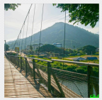
坦波罗里吊桥
